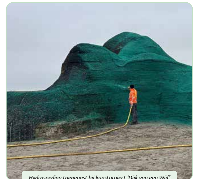
Hydroseeding toegepast bij kunstproject 'Dijk van een Wijf'. (foto Sense of Place)
