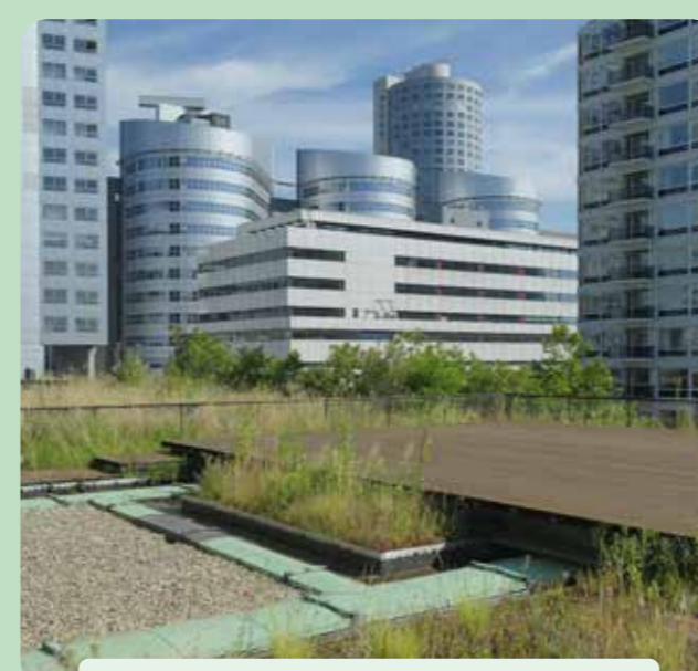
Twee jaar na aanleg.
